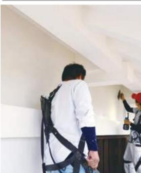
重要文化財を伝統的な技法で 筋鉄御門の修復現場公開 福山城筋鉄御門で、漆喰の全面塗り替え工事が進んでいる。2019年に漆喰が剥がれ落ちたことによる美観向上整備事業。1951年昭和26年から解体修理。1971年、72年(46年)の災害復旧工事による塗り替え。重要文化財として、素材も昔ながらのものを用い、職人による伝統的な技法で行われている。その様子が18日、抽選で選ばれた48人に一般公開された。
